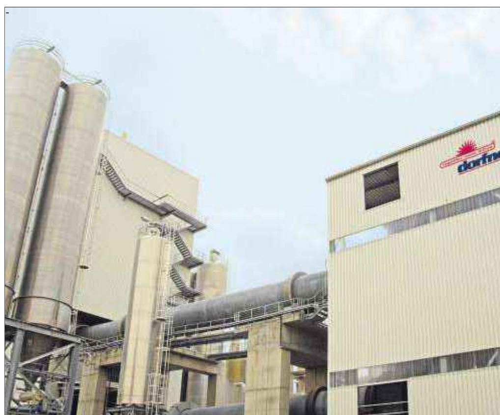
Herzstück des Standorts der Firma Dorfner ist die Kalzinierungs-Anlage: Hier erfolgt die Veredelung der Rohstoffe zu hochwertigen Funktionskomponenten, die beispielsweise in Farben und Lacken Verwendung finden. Der Jahresumsatz beläuft sich auf etwa 60 Millionen Euro. Bilder: privat (2)
