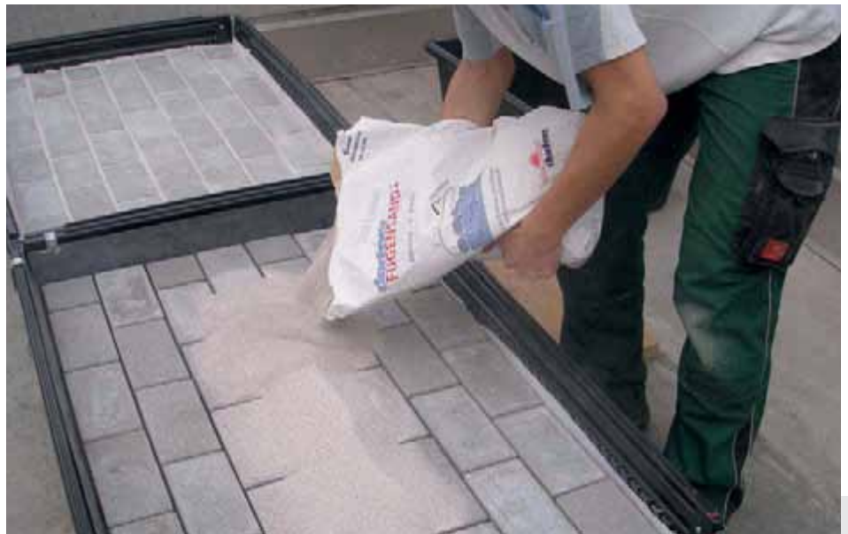
Bild 1: Aufbringen des Fugensandes (Aufnahme 21.01.2010)
